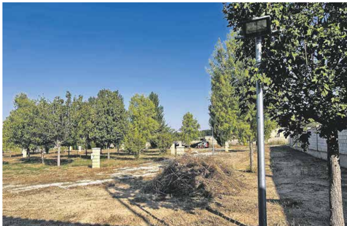
Foto: Comienzo de las obras del área de descanso de autocaravanas, en Daroca. Piensa en Daroca
