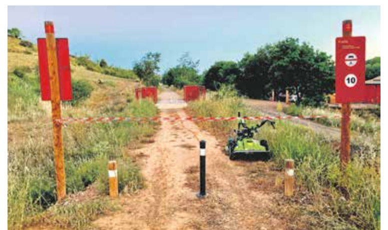
Foto: Labores de desbroce de la Vía Verde. Consejería de Medioambiente
