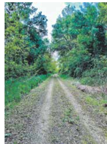
Foto: Estado de la Vía Verde tras los trabajos de limpieza. Medioambiente Comarca de DAROCA
