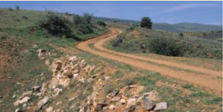
Antigua «Carretera de Madrid», en el término de Daroca
